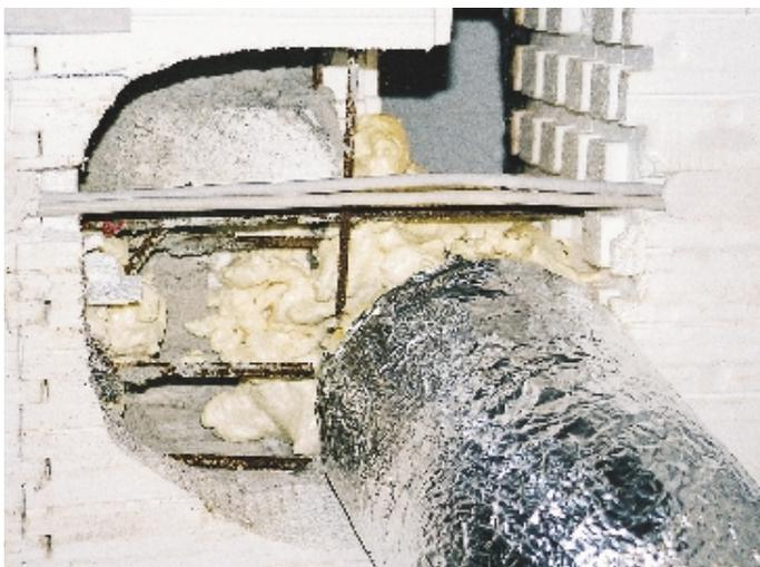
Ganz wichtig: Alle Rohre und Leitungen sollten dick ummantelt und isoliert sein, um ja keine wertvolle Wärme und Energie zu verlieren.
