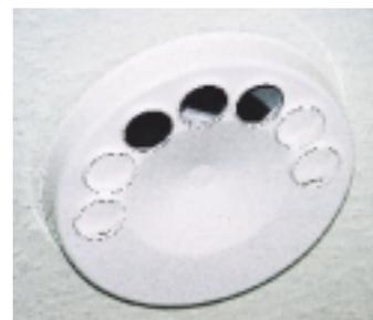
Dezente Ventile in Wand und Decke entlassen die Frischluft zugfrei in die Räume.
