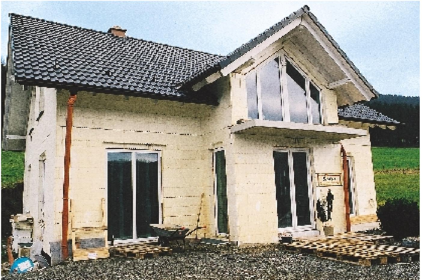
Dieses Bausatzhaus von Bert Fehser liegt mit seinem Jahresheizwärmebedarf um 25 Prozent unter dem Niedrigenergiehausstandard. Damit eignet es sich bestens für das innovative Heizsystem.
